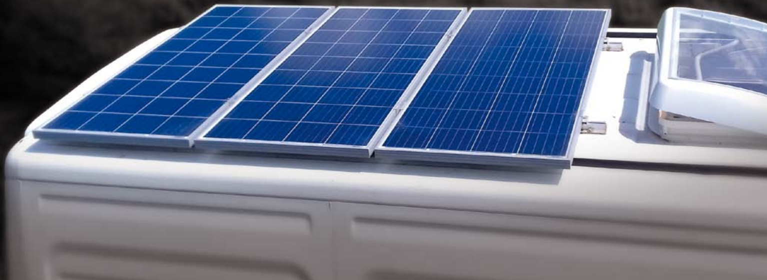
Instalace vzorového karavanu s panely na konstrukci z profilů
